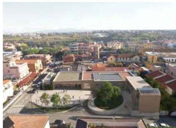
Piazza Giuseppe Meroldi, Montespaccato, Roma, in fase di realizzazione / ongoing, ph. Floer, courtesy Alvisi Kirmoto
