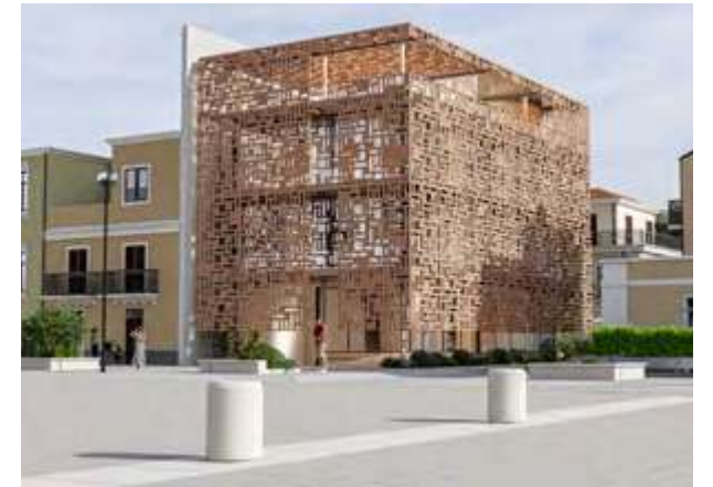
Progetto architettonico con facciata filtrante in terracotta che interpreta il linguaggio mediterraneo / Architectural project featuring a permeable terracotta façade that interprets Mediterranean language © Atelier Iraci Architetti
