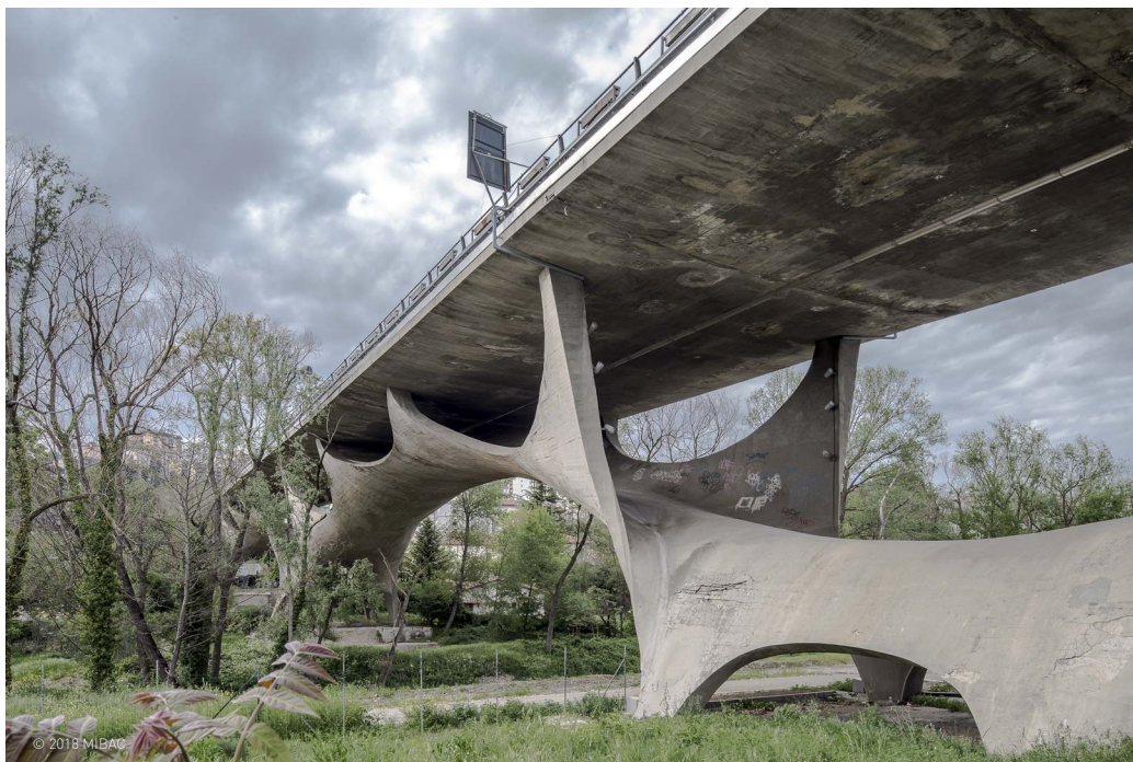
Ponte sul Fiume Basento, Foto di Alessandro Lanzetta
