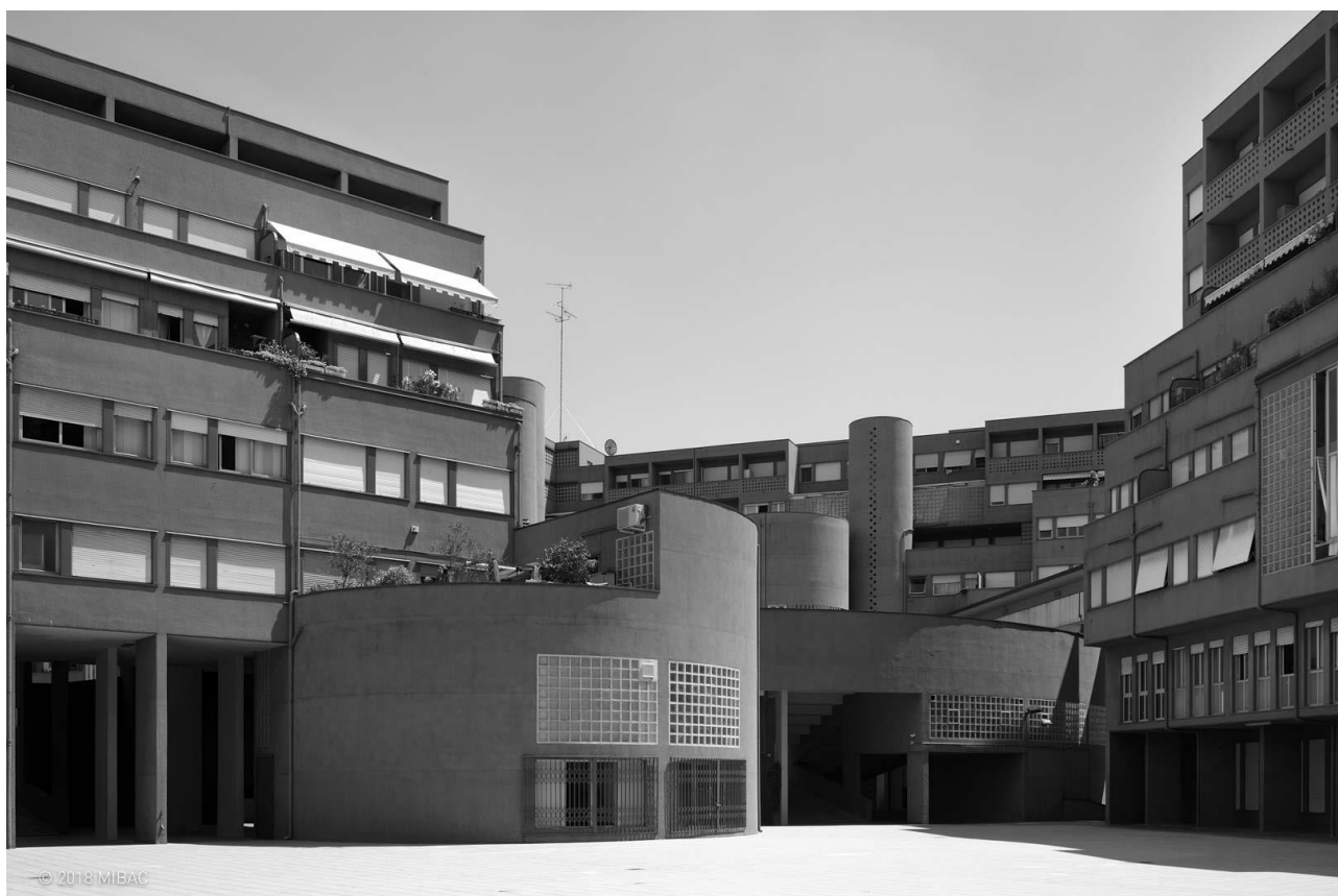
Atlante Architettura Contemporanea (2018) / Unità residenziale Monte Amiata (autori: Carlo Aymonino, Aldo Rossi, 1968-1973); itinerario: Costruire case, fare città . Foto Marco Introini.
